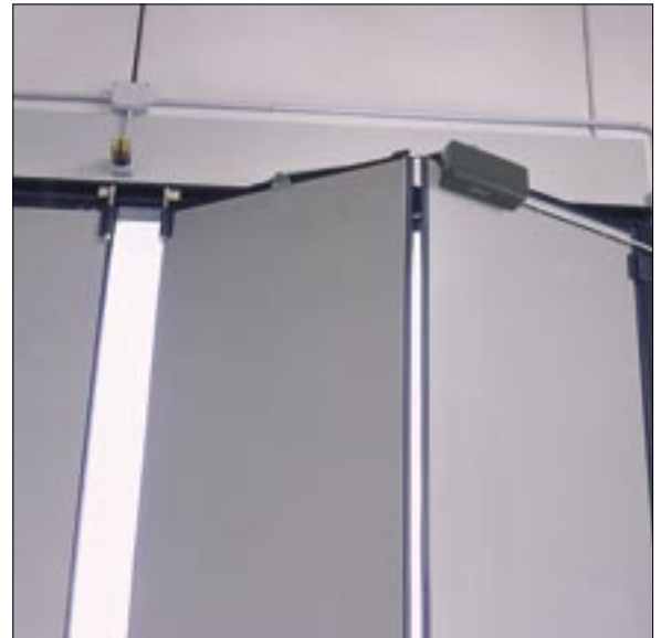
Detail pohonu otevírání
