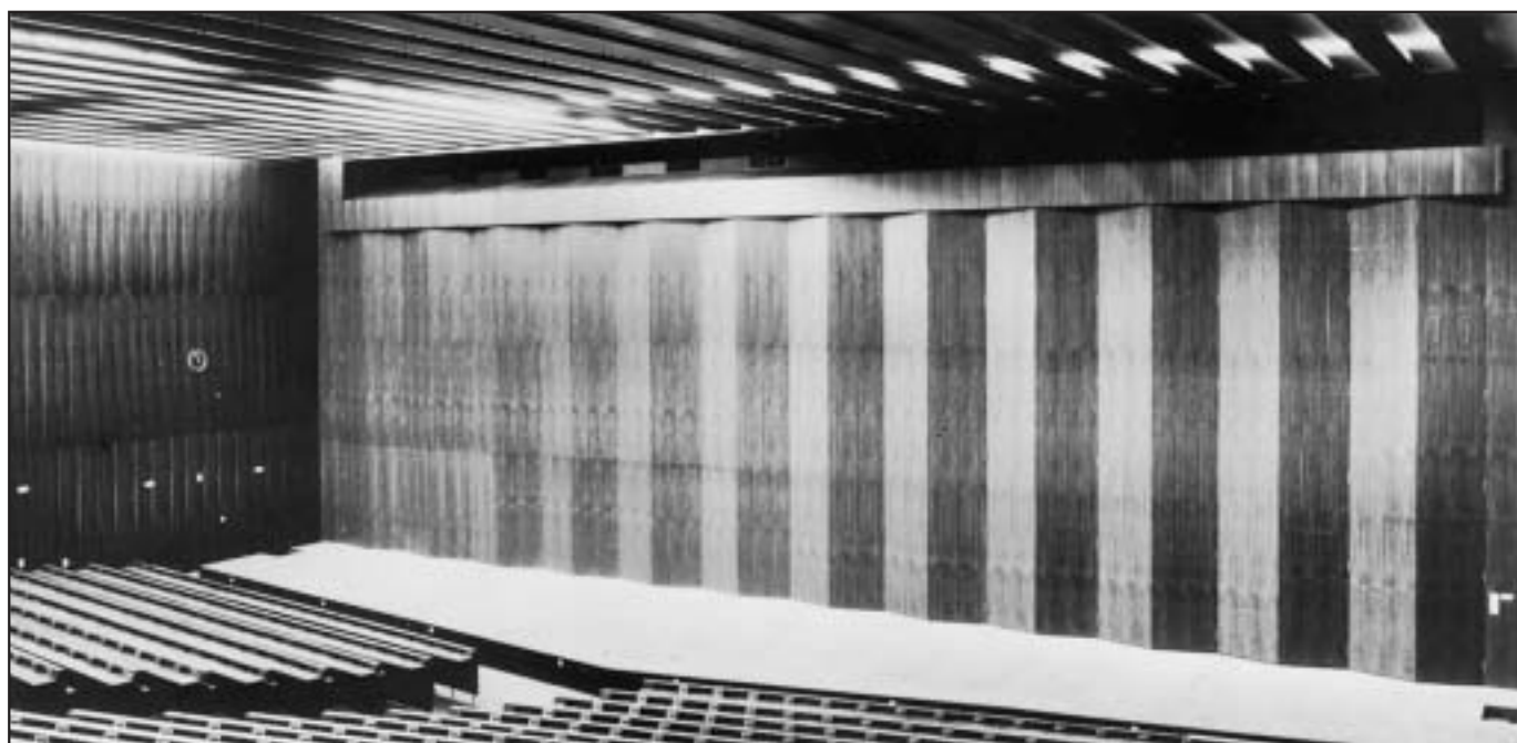
Fig 1 Skládání křídel probíhá jen na jedné straně. Vzhledem k asymetrickému zatížení ve složeném stavu je podmíněčně nutné použít spodní vedení.
