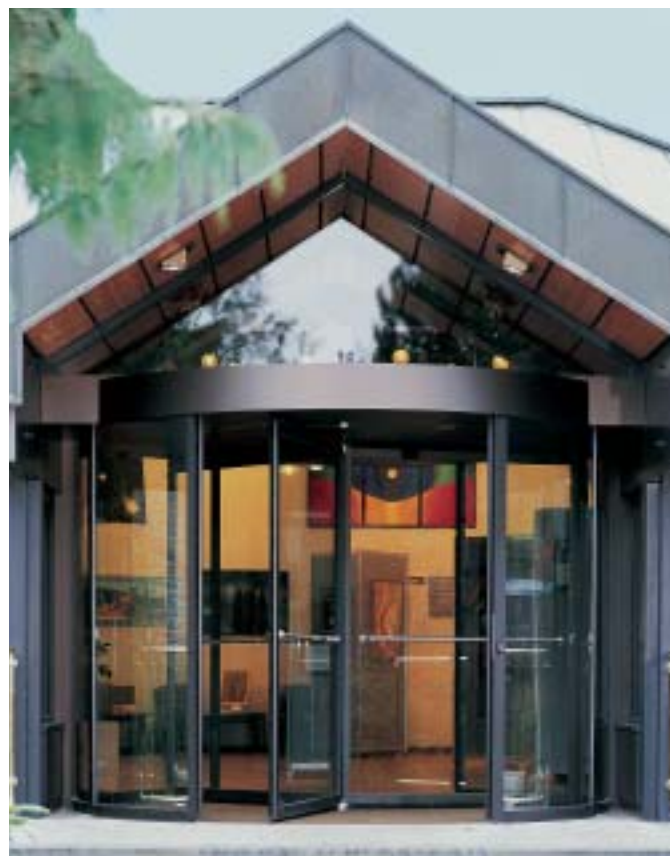
Dům pro Bezpečnost práce, Bad Münstereifel
