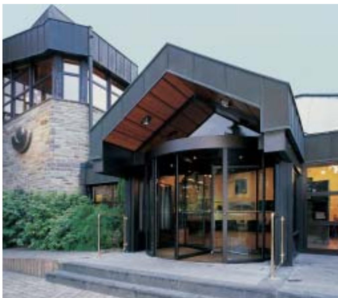
Dům pro Bezpečnost práce, Bad Münstereifel
