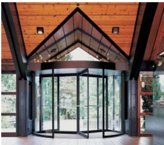
Dům pro Bezpečnost práce, Bad Münstereifel
